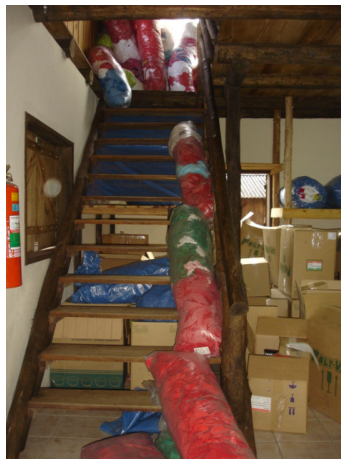
Figura 1: Resíduo armazenado na escada Fonte: Arquivo Pessoal
